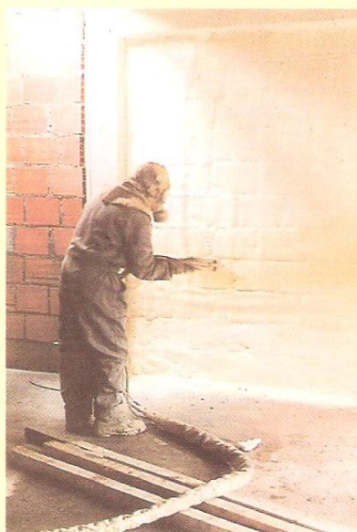
isolamentos por projecção de poliuretano em paredes de habitação
