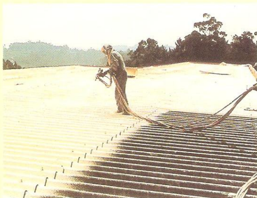
isolamento exterior de coberturas
